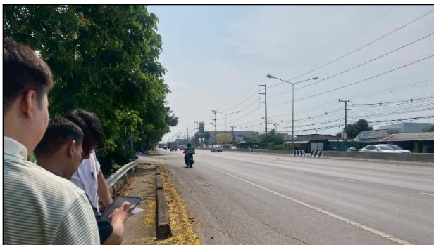
รูปที่ 5 สภาพปัจจุบันของแนวเส้นทางโครงการบริเวณจุดสิ้นสุดโครงการ
