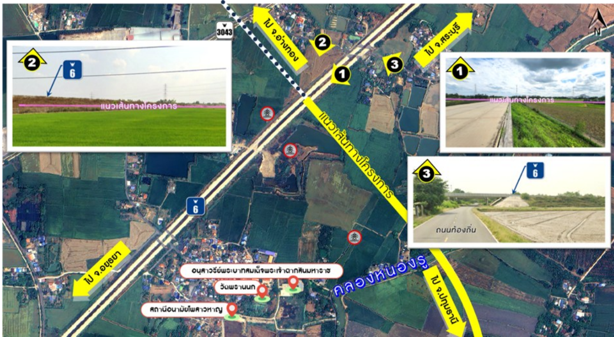
รูปที่ 6 ลักษณะแนวเส้นทางโครงการ ช่วงที่ 1 บริเวณจุดเริ่มต้นโครงการ
